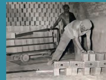
Einschichten der Ziegelrohlinge in die Brennkammer (Ziegelei Schweiger, Göggingen).
